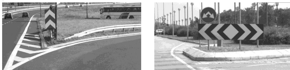
Fot. 1, 2. Elementy drogi wraz z urządzeniami bezpieczeństwa ruchu (PL), (I)
