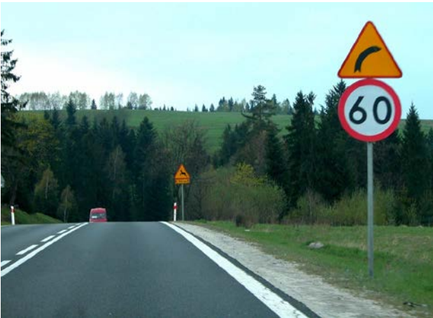
Fot. 14. Znak „ograniczenie prędkości” dotyczący znaku „niebezpieczny zakręt...” (za zakrętem wymaga odwołania) – Polska
