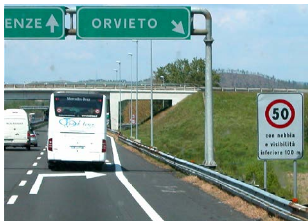
Fot. 9. Znak tablicowy „ograniczający prędkość” w przypadku mgły, gdy widoczność spada poniżej 100 m – Włochy
