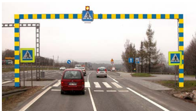
Fot. 7. Oznakowanie przejścia dla pieszych z wizualnym wzmocnieniem (żółto-niebieskim) zamontowanym na bramownicy
