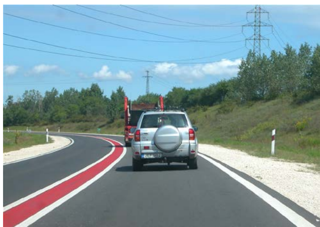
Fot. 1. Czerwony pas podkreślający w wyraźny sposób znaczenie linii (P-4) rozdzielającej przeciwne pasy ruchu (Węgry)
