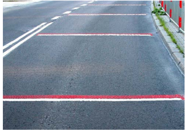
Fot. 10. Linie wibracyjne przed zakrętami w kolorystyce zmodyfikowanej. Dodano biały pasek i „zagięcia” pozorując mini efekt 3D
