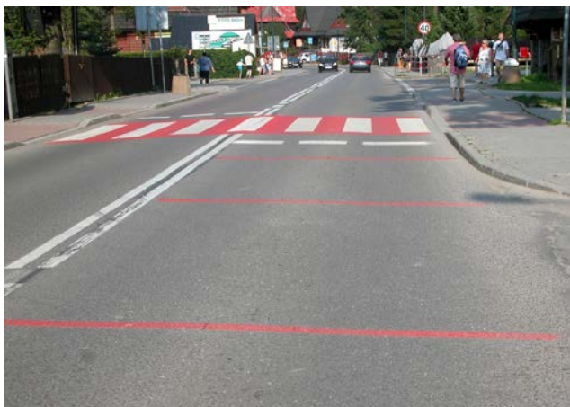
Fot. 7. Oznakowanie przejścia dla pieszych w kolorystyce biało czerwonej wraz z liniami wibracyjnymi
