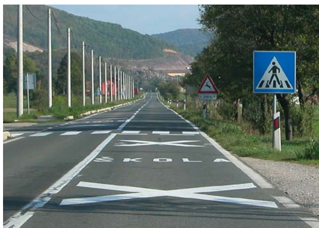
Fot. 2. Oznakowanie informujące o przejściu dla pieszych w rejonie szkoły (Chorwacja)
