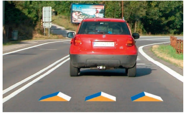
Fot. 1. Brak związku kolorystyki (cienia) brył 3D z cieniem przejeżdżającego pojazdu
