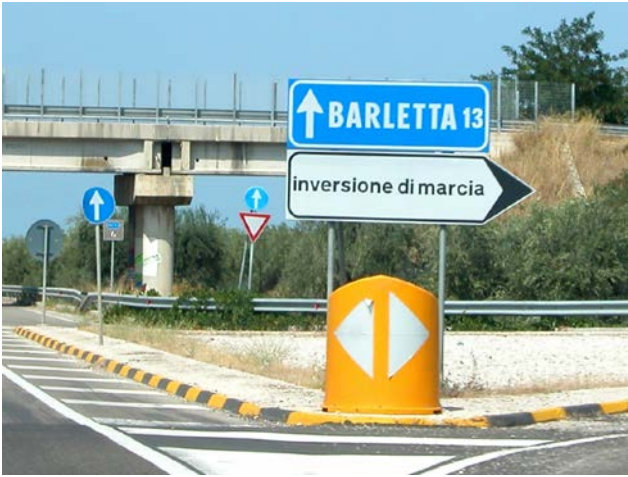
Fot. 5. Przestrzenne oznakowanie krawężnika za pomocą stosowanych na przemian kolorów – tu żółtego i czarnego (Włochy)
