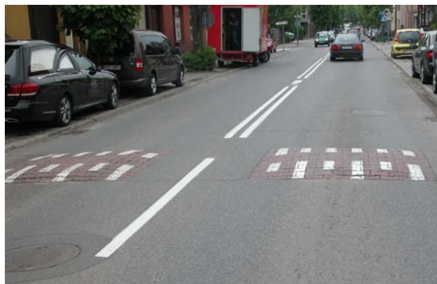
Fot. 3. Dwa progi zwalniające wyspowe, nieznacznie wyróżniające się kolorem z dodatkowym oznakowaniem białymi pasami
