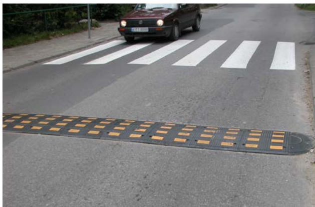
Fot. 2. Próg zwalniający listwowy (U-16d) wyróżniający się kształtem, kolorem oraz oznakowaniem
