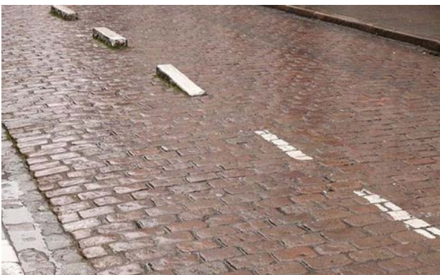
Fot. 8. „Linia pojedyncza przerywana” (P-1) fizycznie wystająca ponad jezdnię (brak informacji, gdzie zrobiono zdjęcie – zostało udostępnione za zgodą administratora strony „fun.noshit.pl”)
