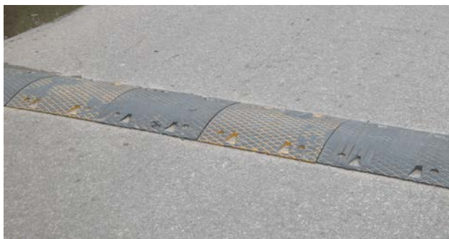
Fot. 1. Próg zwalniający listwowy (U-16d) wyróżniający się kształtem, kolorem, ale też materiały
