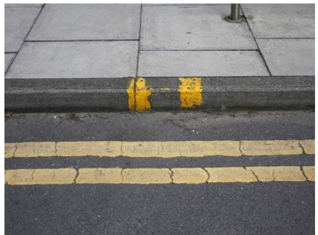
Fot. 7. Podwójny żółty przestrzenny znak na chodniku zakazujący w tym miejscu całkowicie prac przeładunkowych (Londyn)
