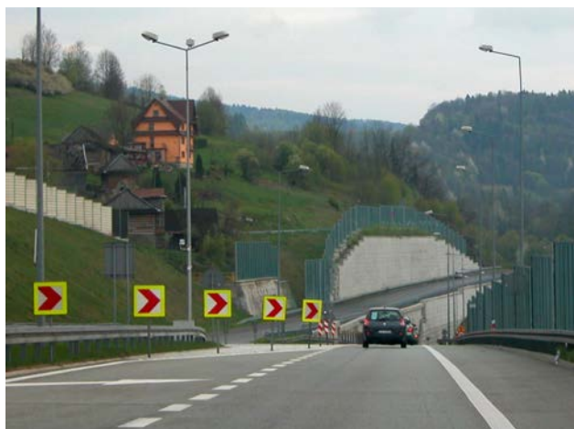
Fot. 9. Przykład użycia tablic prowadzących w miejscu łączenia się dwóch pasów ruchu w jeden. Tablicom dodano żółtą, odbłaskową obwódkę zwracając dodatkowo uwagę na to oznakowanie
