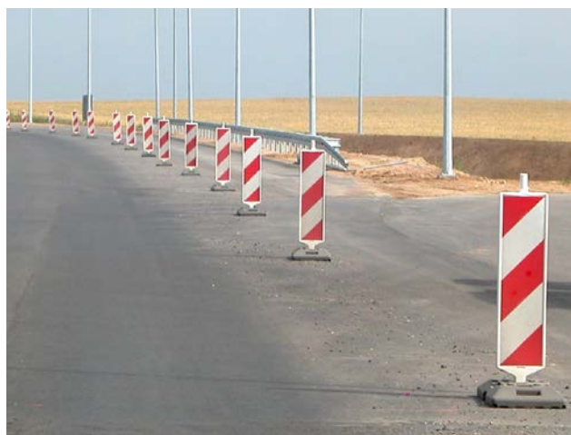
Fot. 6. Zestaw tablic kierujących, niejednokrotnie stosowanych na zewnętrznej stronie łuku, zabezpieczające go zwłaszcza przy braku oznakowanego pobocza, czy linii krawędziowej
