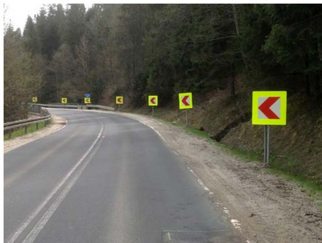
Fot. 5. Zestaw tablic prowadzących pojedynczych w lewo (U-3b) na zewnętrznej stronie łuku z odblaskowym obramowaniem
