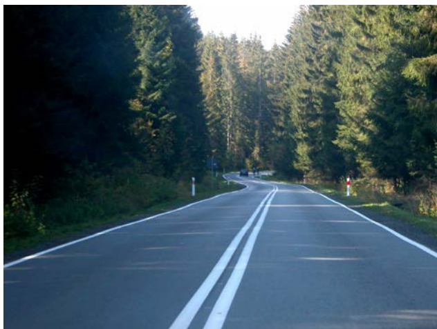
Fot. 10. Podwójna linia ciągła zabraniająca przejeżdżania przez tę linię i najeżdżania na nią, stanowiąca zakaz wyprzedzania na widocznym, dość długim odcinku drogi
