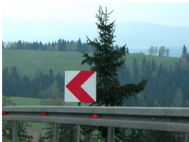
Fot. 1. „Tablica prowadząca pojedyncza w lewo” (U-3b)
