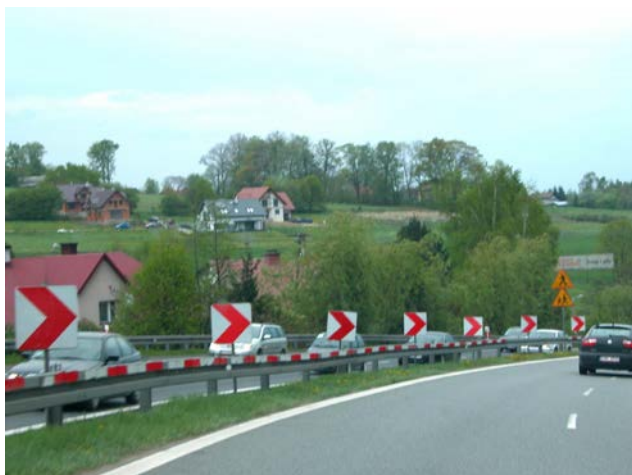
Fot. 4. Zestaw tablic prowadzących pojedynczych w prawo (U-3a) na zewnętrznej stronie łuku o dużym promieniu
