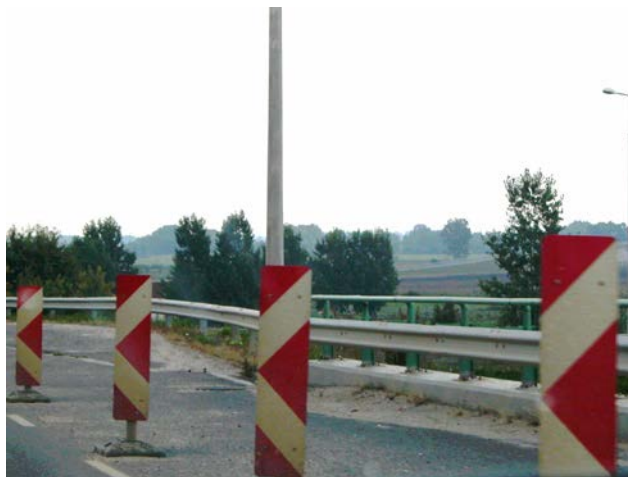
Fot. 8. Tablice kierujące z odmiennym oznakowaniem, gdzie rysunek nawiązuje do tablic prowadzących. Są to podobnie groty strzałek w kształcie znaku mniejszości „<” lub większości „>” (Węgry)
