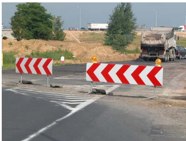
Fot. 2. Dwie „tablice prowadząca ciągła w lewo” (U-3d)
