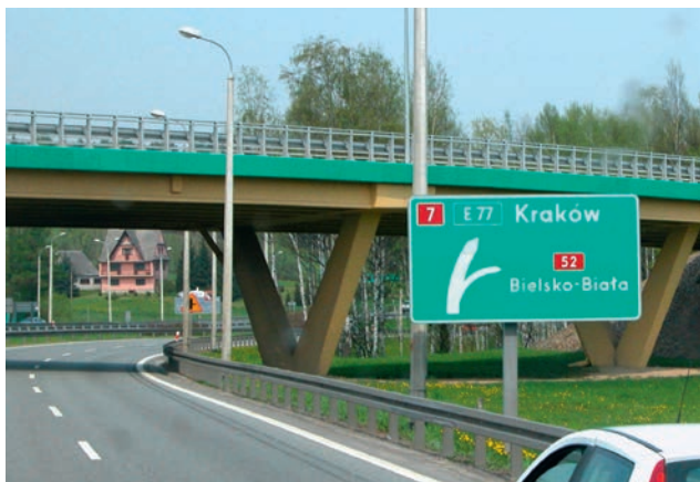
Fot. 4. Tablica przeddrogowskazowa wskazuje schemat rozgałęzienia dróg, z którego wynika, iż zjazd z drogi głównej (na drogę nr 52) skręca nieco więcej, niż sama droga
