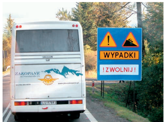
Fot. 3. Niekonwencjonalna tablica informująca w nieprecyzyjny sposób o rejonie wypadków. Użyto nieprecyzyjnego znaku „inne niebezpieczeństwo” i dwóch napisów „WYPADKI” oraz „! ZWOLNIJ!”. Jedynie znak „niebezpieczny zjazd” (A-22) podaje konkretną informację
