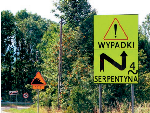
Fot. 2. Niekonwencjonalna tablica informująca o niebezpiecznych zakrętach – 4 serpentynach, ostrzegająca o rejonie wypadków i poprzedzająca znak ostrzegawczy „niebezpieczny zjazd” (A-22)
