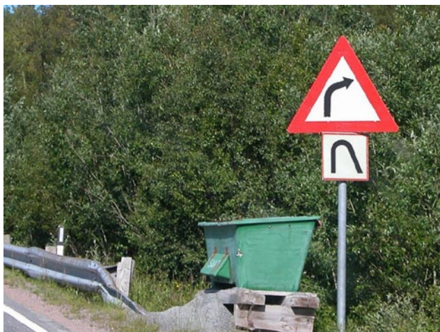
Fot. 7. Znak „niebezpieczny zakręt w prawo” z dodatkową tabliczką ukazującą rzeczywisty kształt zakrętu (Norwegia)
