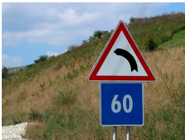
Fot. 1. Znak „niebezpieczny zakręt w lewo” z tabliczką „zalecana prędkość 60 km/h” (Słowacja)
