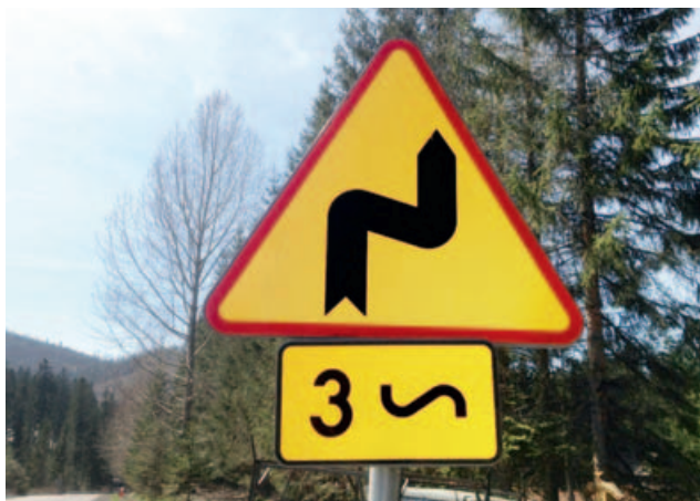
Fot. 1. Znak „niebezpieczne zakręty – pierwszy w prawo” (A-3) z tabliczką wskazującą początek drogi krętej (T-4)
