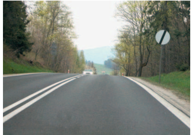
Fot. 6. Znak „koniec zakazów” (B-42) pojawiający się z opóźnieniem za końcem łuku (zakrętu), który odwołuje ograniczenie prędkości.
