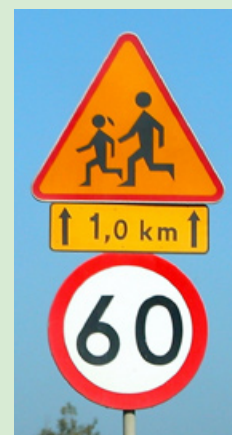
Fot. 8. Nietypowe oznakowanie ostrzegające o możliwości poruszania się dzieci na drodze, na odcinku 1 km (z ograniczeniem prędkości)
