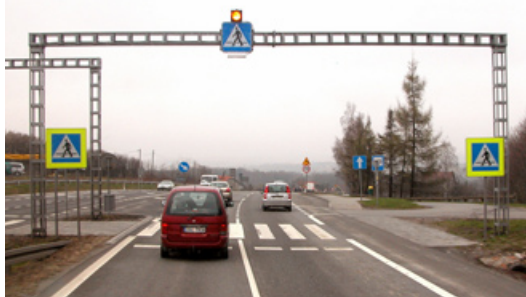
Fot. 3. Bramownica dla znaku „przejścia dla pieszych” (D-6) oraz dla pulsującej sygnalizacji świetlnej (w rejonie ograniczenia 70 km/h)
